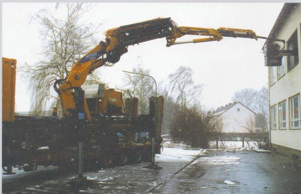
Zwischen Hallendach und Zwischenbühne werden Stahlträger montiert. Damit der einzelne Stahlträger schnell und präzise am vorgesehenen Ort positioniert und ausgerichtet werden kann, muß der Gelenkarm parallel zur Zwischenbühne teleskopiert werden. Der Kompaktkran wird deshalb mit den Abstützungen ca. 1m über den Hallenboden angehoben.
